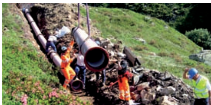
Pose de tubes en milieu alpin
