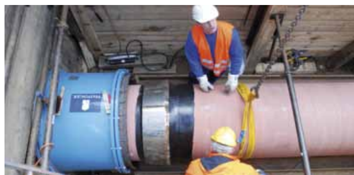
Pose en fourreau
