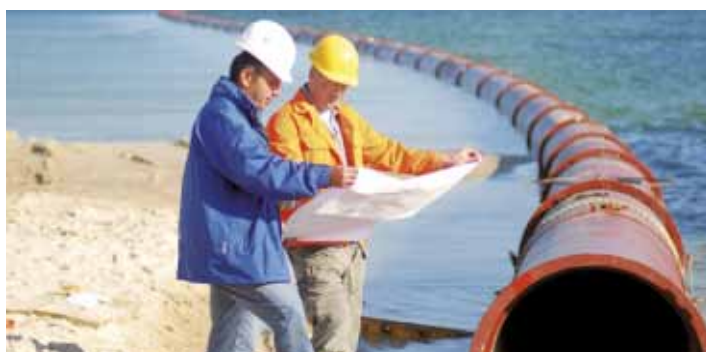
Pose par flottaison d'une canalisation en fonte ductile
