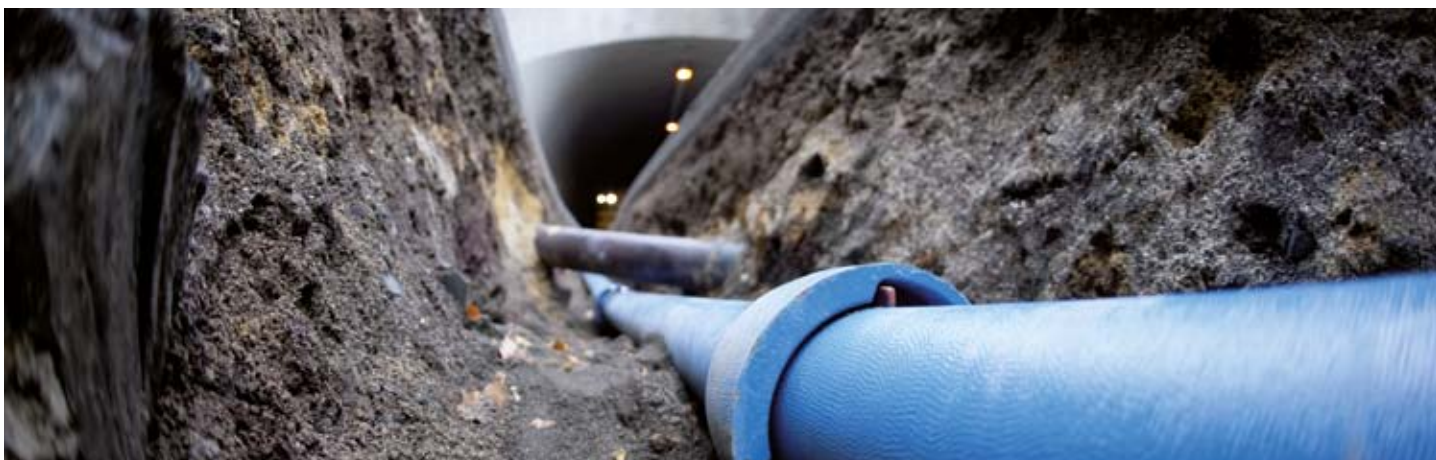
Utilisation de tubes BLS®/VRS®-T pour l'installation d'une canalisation incendie dans un tunnel
