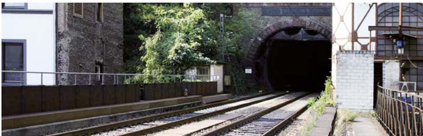
Tunnel du Cochem
