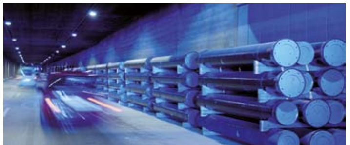
Tunnel du Plabutsch près de Graz (Autriche)
