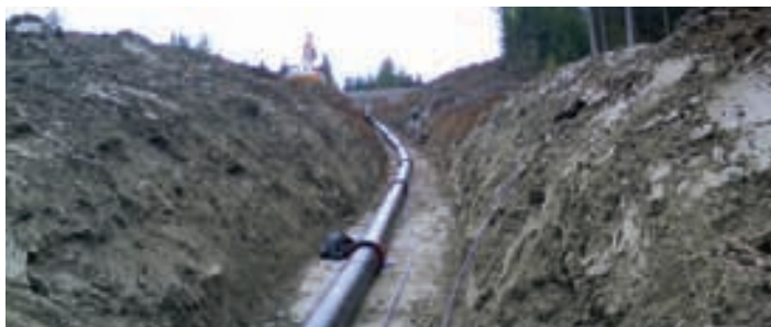
Déviation angulaire jusqu'à 5°, économie de temps et de raccords
