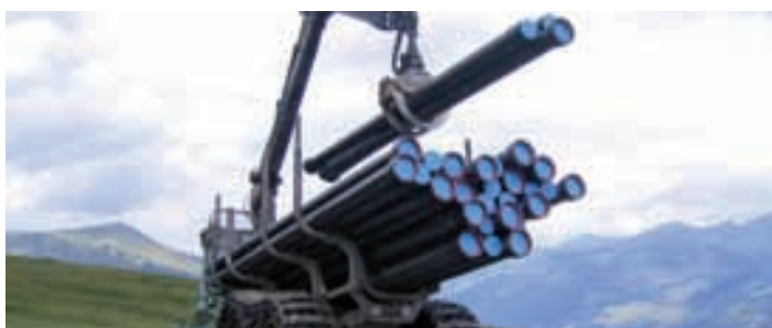
Déchargement de tubes à l'aide d'appareils spéciaux – Bergbahnen AG Kitzbühel, Autriche
