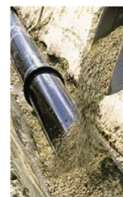
Facilité de pose
