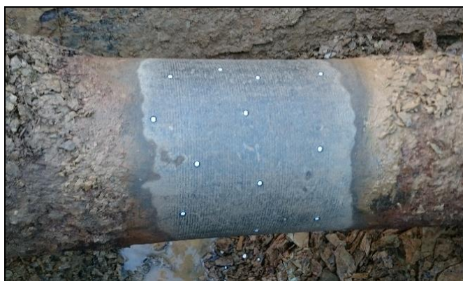
Préparation et mise en place des cibles
